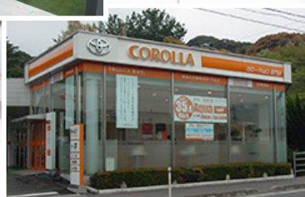
施工事例：トヨタカローラ山口 長門店
